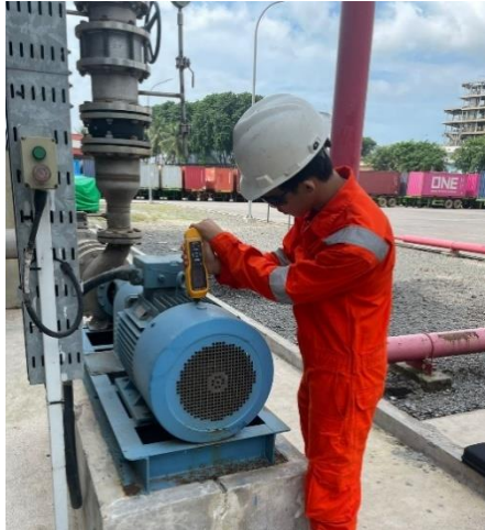
Gambar 4. 1 posisi pengukuran NDE dilapangan
