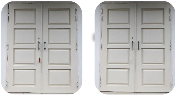
Gambar 3.3 Visualisasi perangkat Akses Kontrol pada pintu Ruang 1, PT.Telkom Indonesia
