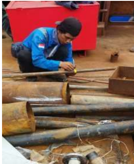
Gambar 4: Proses pengukuran dan pemotogan pipa
