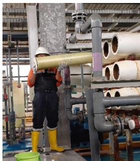
Gambar 2. 3 Pembongkaran Membrane
