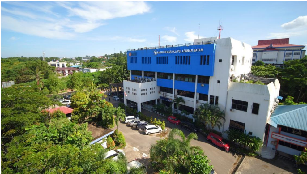
Gambar 1 - 1 Bangunan Bup Bp Batam, Batu Ampar
