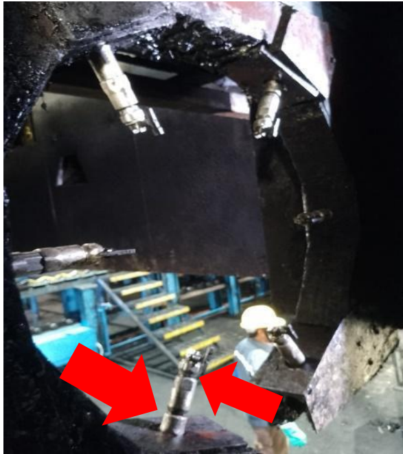
Gambar 4 Pemasangan nozzle
