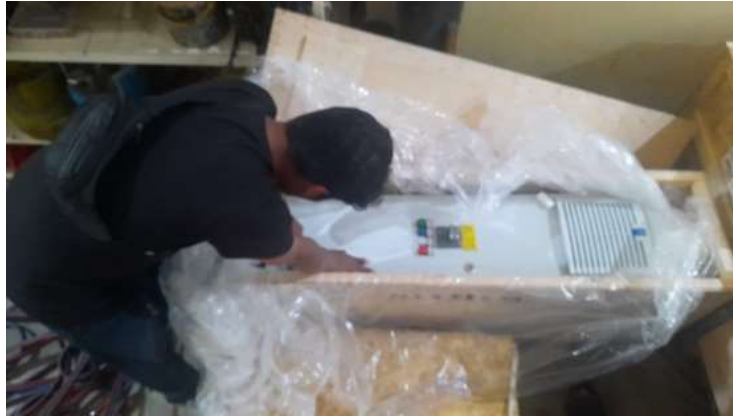
Gambar 8 Pemasangan unit baru
