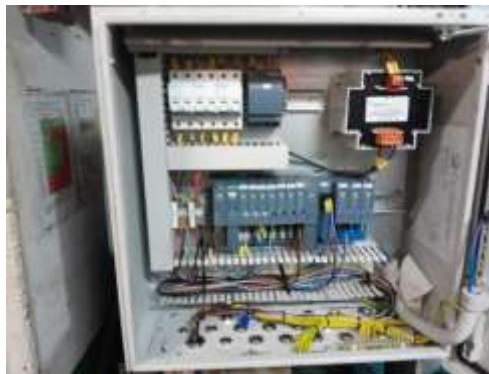
Gambar 9 proses pemasangan mccb
