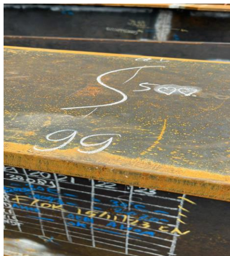
Gambar 5. Pembuatan Section Girder (Sumber: Dokumentasi Pribadi 2023)
