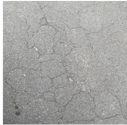
Gambar 1. Retak Buaya (Ringan)
