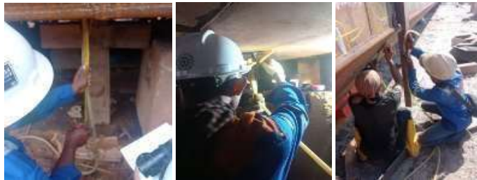
Gambar 4. Proses Pemasangan Selang Air Pada Setiap Frame
