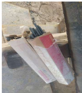
Gambar 13 Kondisi Elektroda/Kawat Las Yang Lembab
