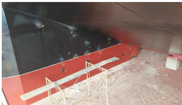
Gambar 9 Kondisi Setelah Repair Tidak Ada Kebocoran
