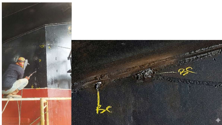
Gambar 8 Proses Repair Kebocoran Menggunakan SMAW
