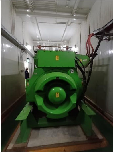
Lampiran 3. Tampak samping Generator Sinkron pada Engine unit 7 Panaran 2
