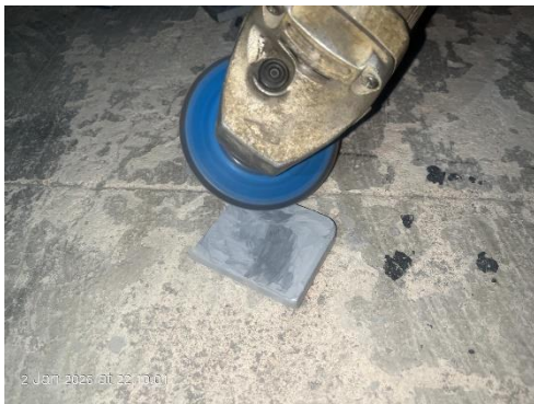
Gambar 4. Hasil St 3 Menggunakan Power Tool
