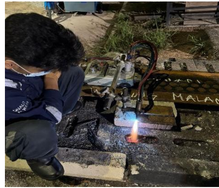
Gambar 4 Proses pemotongan material.
