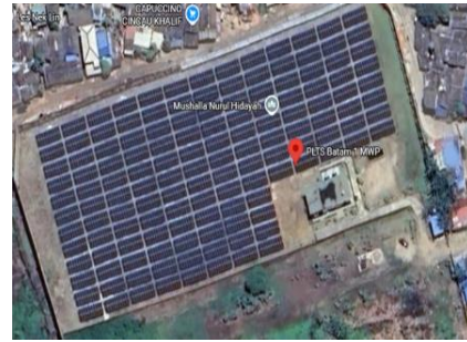
Gambar 1: Lokasi PLTS On-Grid 1 MWp Tanjung Uma
