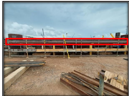
Gambar 9. Tampilan Girder setelah proses fit up dan setelah pengukuran
