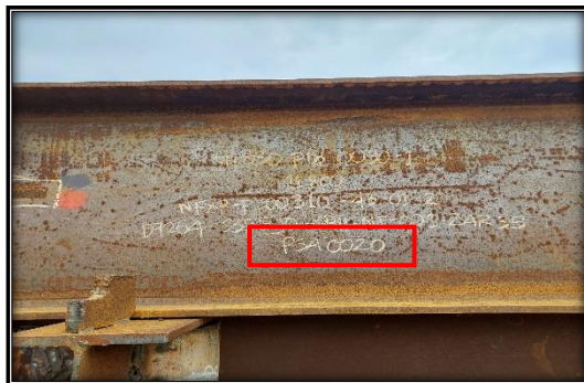
Gambar 11. Efek Data Straightness pada girder G1830PSA0020
