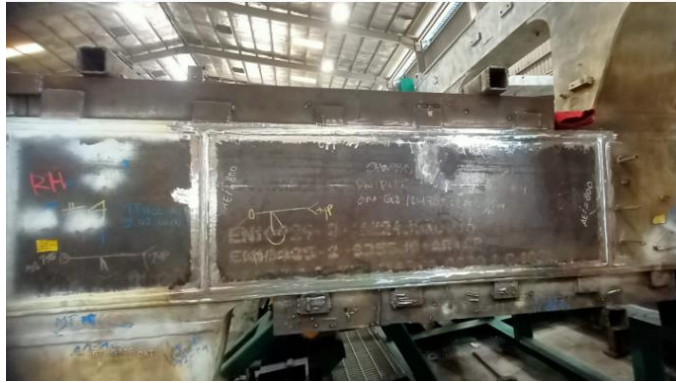
Gambar 4. Hasil dari pemasangan replace material pada chassis truck tambang
