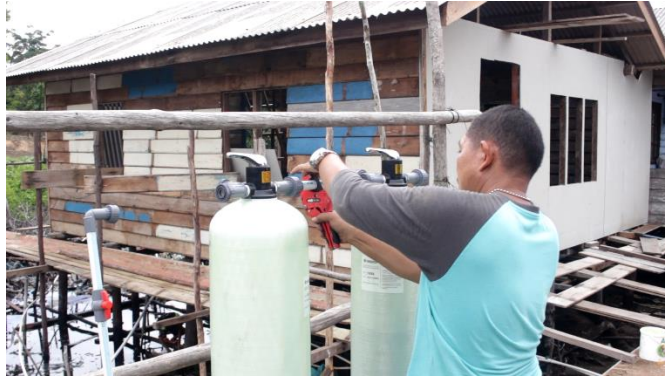
Gambar 3. Dokumentasi proses pembangunan instalasi filter air bersih
