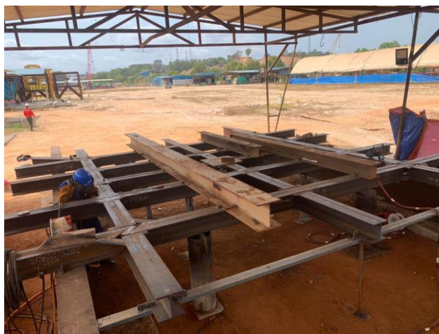
Gambar 8. Kondisi aktual area fabrikasi struktur clump weight CW-1 di PT. VME Process, Batam
