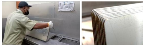
Gambar 29. Setelah Perbaikan : Menggunkan Penyangga
