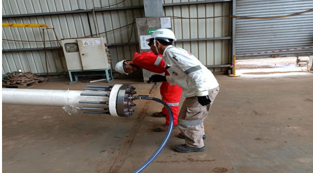
Gambar 4.5. Ilustrasi proses pengisian air ke dalam pipa
