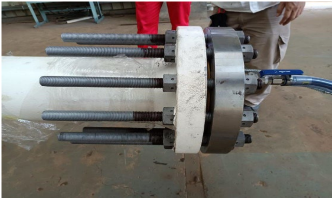
Gambar 4. 4. Pengisian air pada test pump
