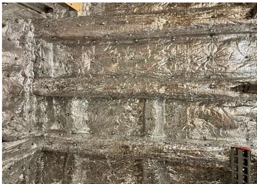
Gambar 4 Kondisi Aktual pemasangan HV Room dengan Proteksi A-60 (a) Material A-60 (b)
