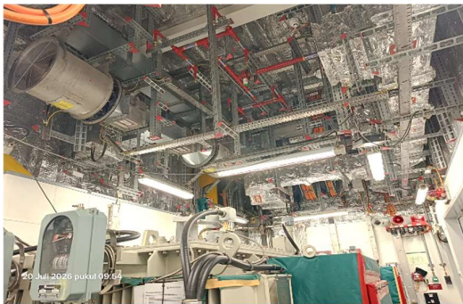
Gambar 5 Kondisi Aktual pemasangan Transformer room dengan Proteksi A-60 (a) Material H-60 (b)
