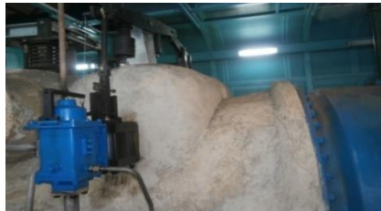
Gambar 2.7 Katup Ekstraksi Turbin
