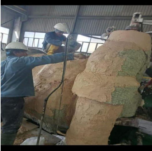
Lampiran 1. Memperbaiki castable turbin
