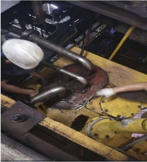
Lampiran 4. Membersihkan jalur oil cooler
