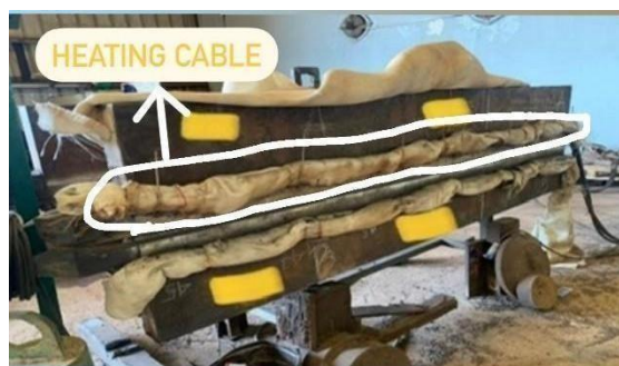
Gambar 7. Pemasangan Heating Cable Di Material Secara Memanjang
