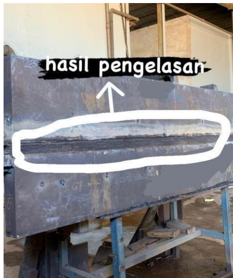
Gambar 8 . Material S420 Tidak Ditemukan Crack Secara Uji Visual
