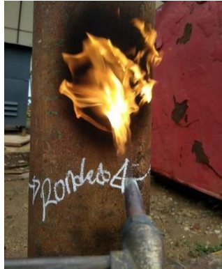
Gambar 8 : Proses repair menggunakan metode fairing
