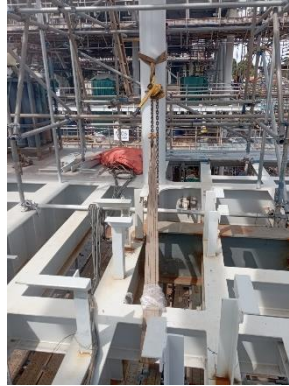
Gambar 9 : Proses penarikan coloumn setelah di fairing
