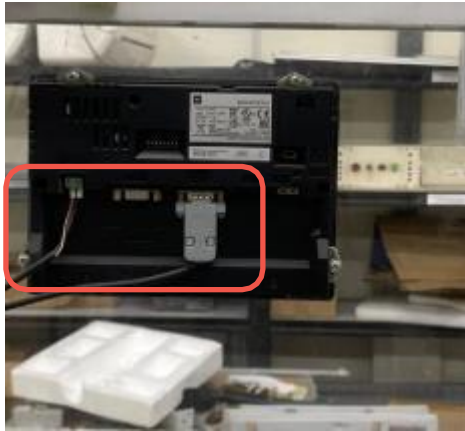
Gambar 14 Pemasangan Power dan Kabel Komunikasi (HMI)
