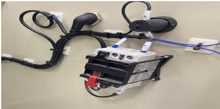
Gambar 8 Pemasangan Wiring pada Pintu Panel
