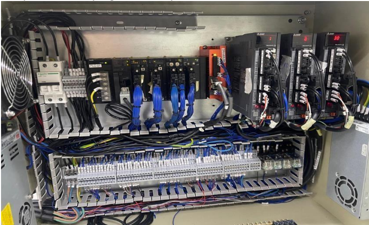
Gambar 24 Instalasi Komponen Secara Fisik didalam Panel
