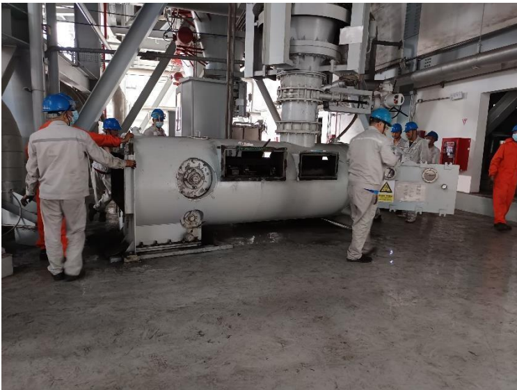
Gambar 24 Maintenance pada Coal Feeder
