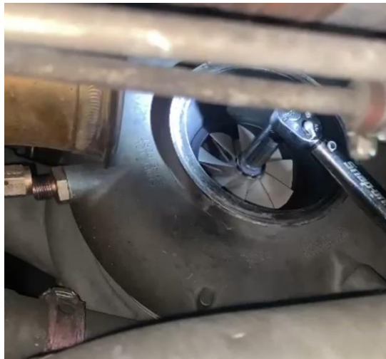
Gambar 6: Pengecekan putaran fan impeller ACM menggunakan torque wrench
