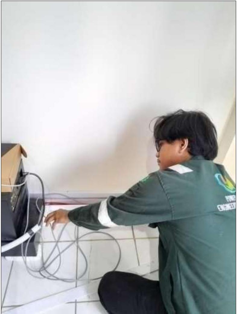
Gambar 4. Pemasangan kabel komunikasi relay proteksi
