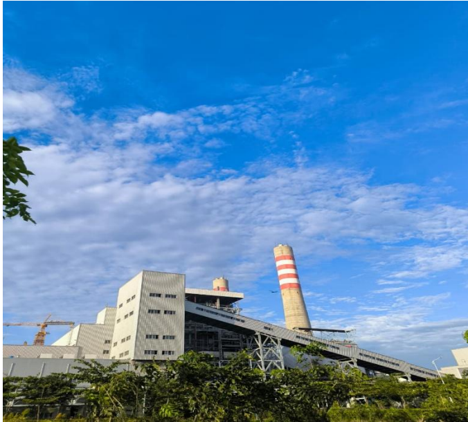
Gambar 1. PLTU PT Bintan Alumina Indonesia
