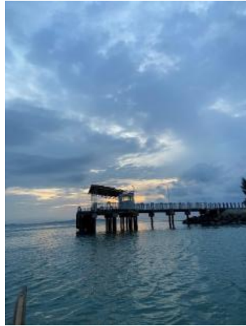
Gambar 41. Kondisi Dermaga Pengujian Sinyal Alarm dari Kapal
