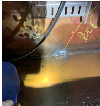
Gambar 10. Hasil perbaikan pengujian Air Pressure Test setelah repair
