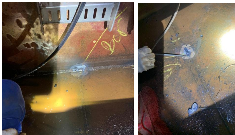
Gambar 4. 5 Melakukan Perbaikan (Repair) pada Area yang Mengalami Kebocoran (Gambar Pribadi)
