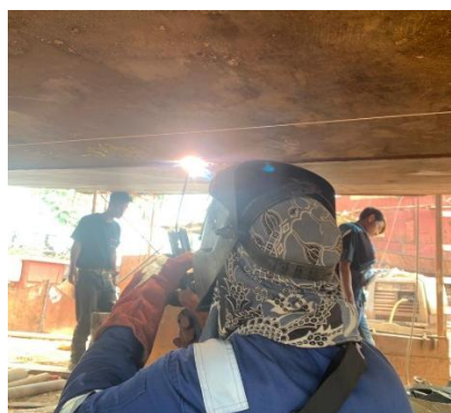
Gambar 8. Proses perbaikan ( repair ) pada titik kebocoran hasil Air Pressure Test
