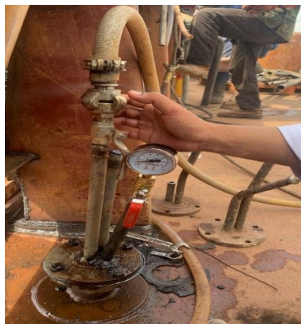
Gambar 3. 5 Pipa input dan Output/Pipa Penetrasi dari Pipa Udara, Valve dan Pressure Gauge (Gambar Pribadi)
