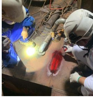
Gambar 5. Pengujian Penetrant Test pada sambungan las Fuel Oil Tank
