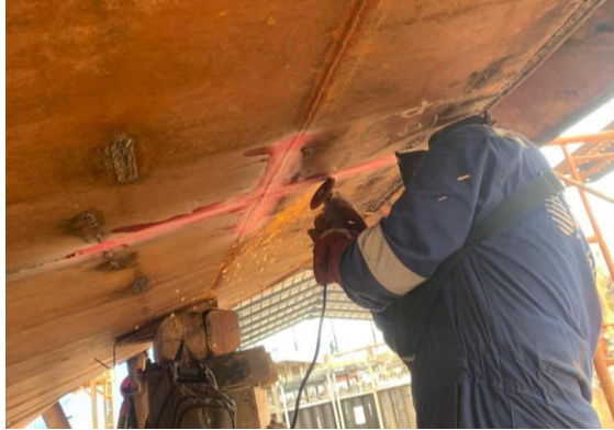
Gambar 3. 16 Melakukan Perbaikan Pada Area Welding Yang Memiliki Cacat Las Melebihi Batas Toleransi (Gambar Pribadi)
