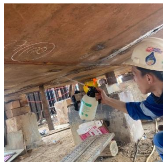
Gambar 4. Pengujian Air Pressure Test pada sambungan las Fuel Oil Tank
