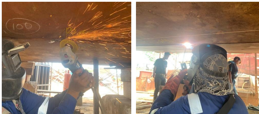
Gambar 4. 5 Melakukan Perbaikan (Repair) pada Area yang Mengalami Kebocoran (Gambar Pribadi)
