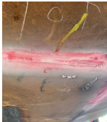
Gambar 11. Hasil perbaikan pengujian Penetrant Test setelah repair
