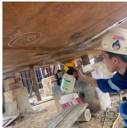
Gambar 3. 10 Melakukan Penyemprotan Menggunakan Air Sabun pada Area Welding dan Melakukan Pemeriksaan Visual pada Area Welding yang Terkena Penyemprotan Air Sabun (Gambar Pribadi)
