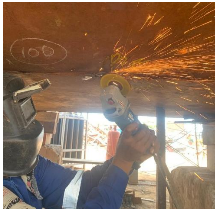
Gambar 3. 11 Melakukan Perbaikan pada Area Welding yang Mengalami Kebocoran (Gambar Pribadi)
