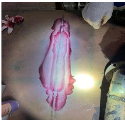
Gambar 4. 7 Hasil Penetrant pada Sampel 1 – Groove Weld Area Tank Top (Gambar Pribadi)
