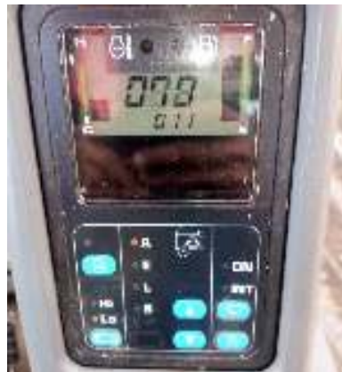
Gambar 7: Tampilan Nilai Tekanan Monitor Panel (setelah perbaikan)
