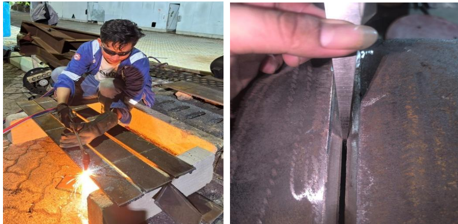
Gambar 3. 3 Proses Preparasi Material Pemotongan dan Fit-up
