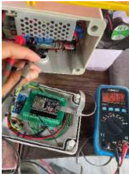
Gambar 25. Pengukuran output voltage humidifier menggunakan multimeter
