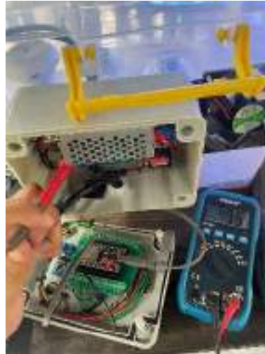
Gambar 27. Pengukuran output voltage LED menggunakan multimeter.
