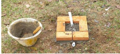
Gambar 20. Pondasi tiang lampu taman.
