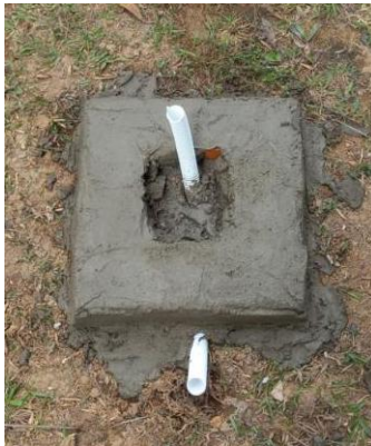
Gambar 21. Menutup batu bata dengan campuran semen.
