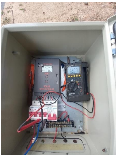
Gambar 27. Pengukuran tegangan pada baterai menggunakan multimeter .
