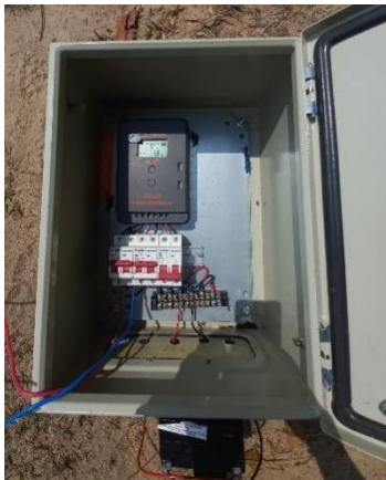
Gambar 25. Pengukuran arus panel surya pada MPPT.
