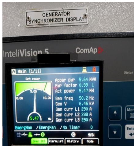
Gambar 12. Tampilan Daya Keluaran saat Kondisi Derate 30% pada Panel GCC
