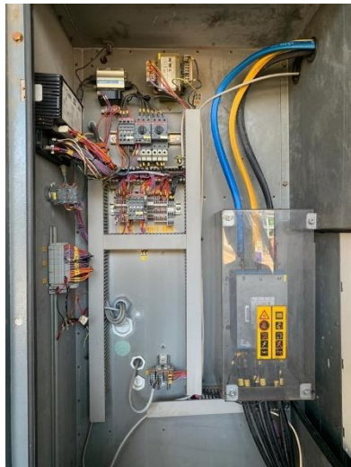
Gambar 3. 7 Rangkaian motor induksi menggunakan pengaturan VSD
