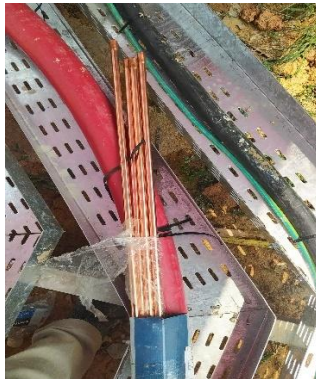
Gambar 1. Elektroda batang
