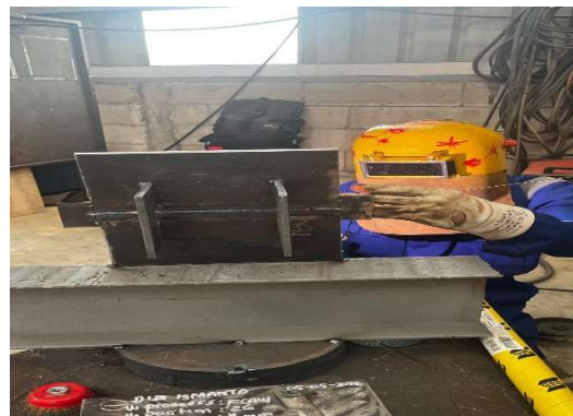
Gambar 11. Posisi Pengelasan GTAW 2G
