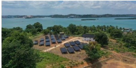
Gambar 1. PLTS Pulau Akar
