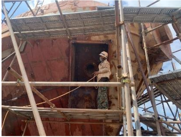
Gambar 3. Pengujian air test
