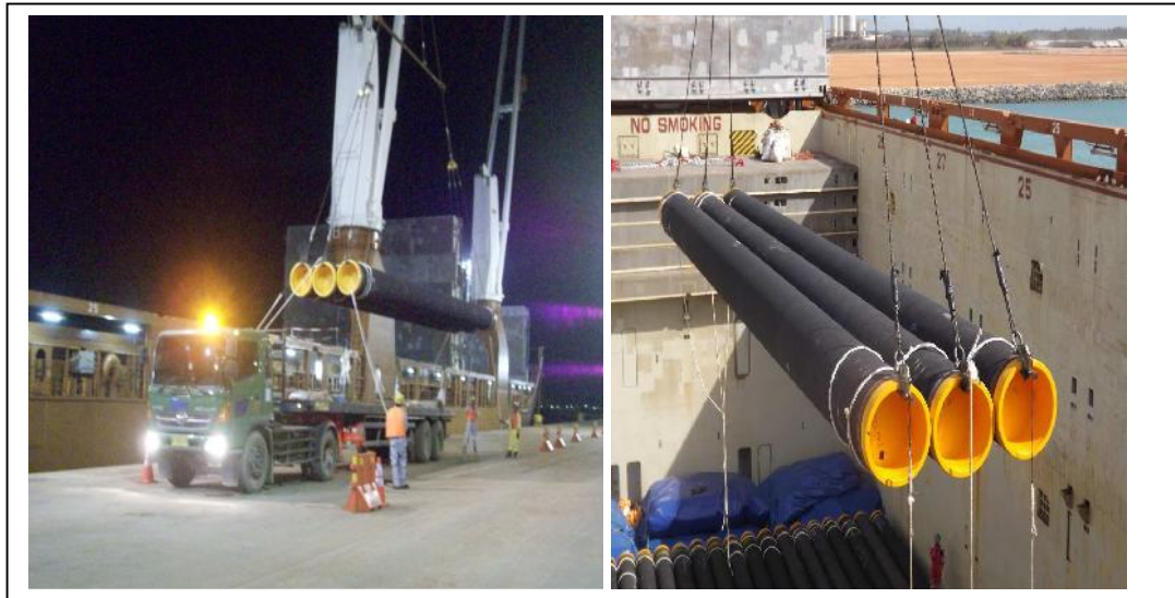
Gambar 2 Proses Bongkar Pipa dari Kapal ke trailer
