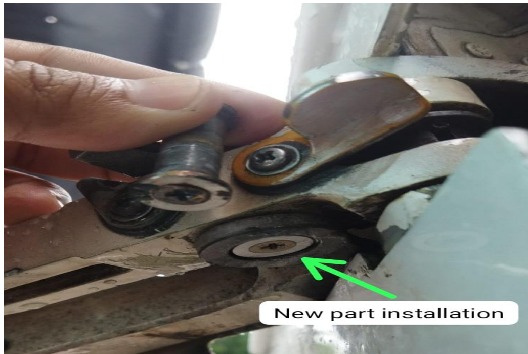
Gambar 6 : pemasangan part yang baru ( screw, washer, and pin assy )
