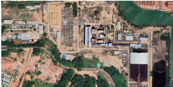
Gambar 10 Lokasi PLTU PT TJK POWER[15]
