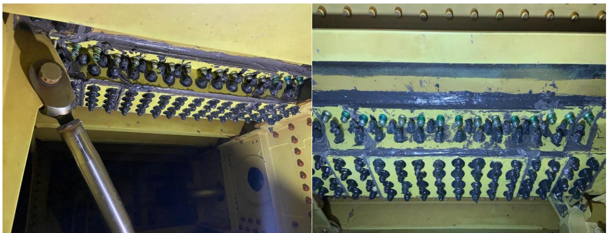
Gambar 8. Hasil Repair pada Vent Stinger-12
