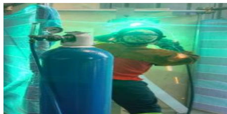
Gambar 12: proses pengelasan 4G
