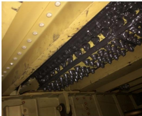
Gambar 13 : Vent Stringer setelah perbaikan
